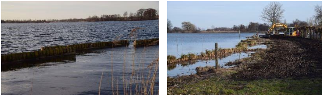
Figuur 19 Effect van een vooroevers beschoeiing op golfslag (links) en aanleg natuurvriendelijke oever in uitvoering (rechts). (Fotograaf: M.M. Visser)
