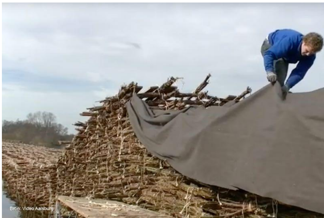
Figuur 27 Zinkstuk aanbrengen van wiepen in Loosdrechtse plassen. Bron: Aalburg.
