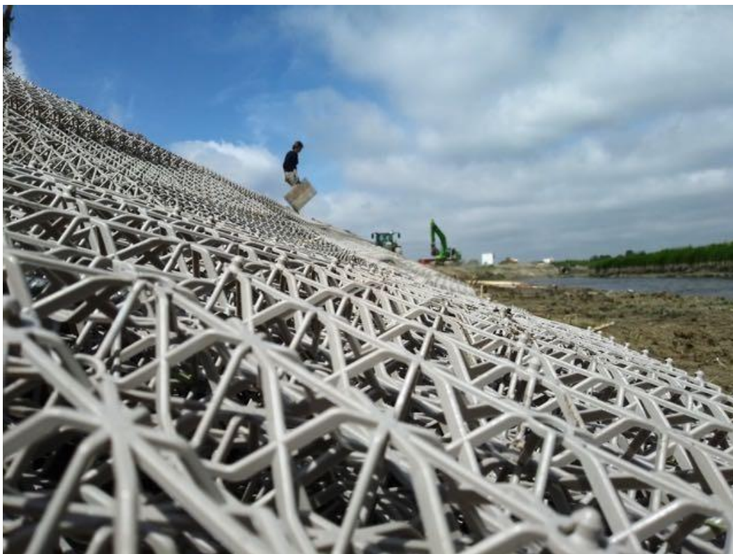
Figuur 32 Aanleg van BESE-elementen. Foto: Bureau Waardenburg
