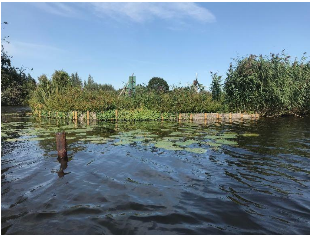
Figuur 28 Versterkte oever van legakker met BESE, proef Nederhorst-Den Berg
